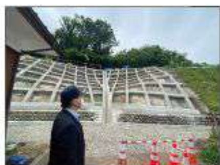
⑩ 飯田被災現場復旧工事現場説明会 (山形市)
